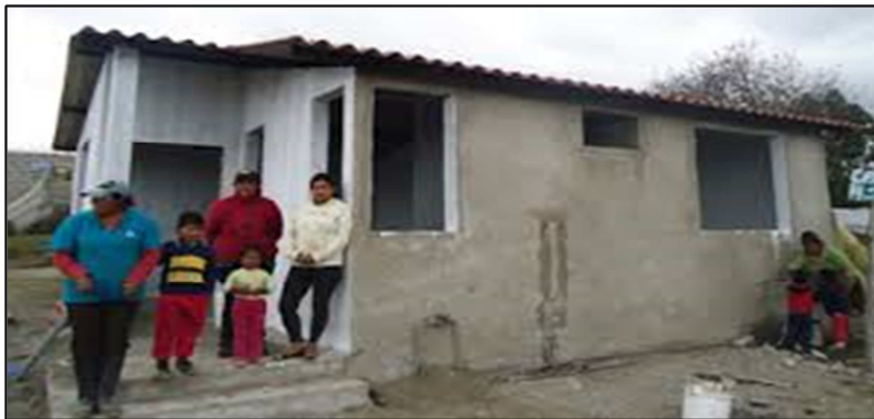
Figura 6. Infraestructura de viviendas Pastocalle
