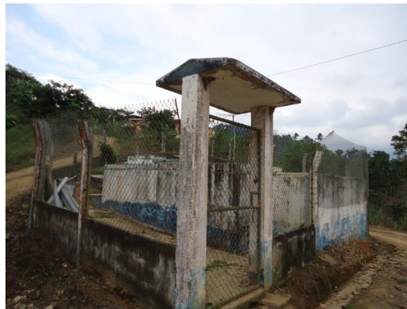
Fotografía 16. Planta de tratamiento de agua Bellamaría
