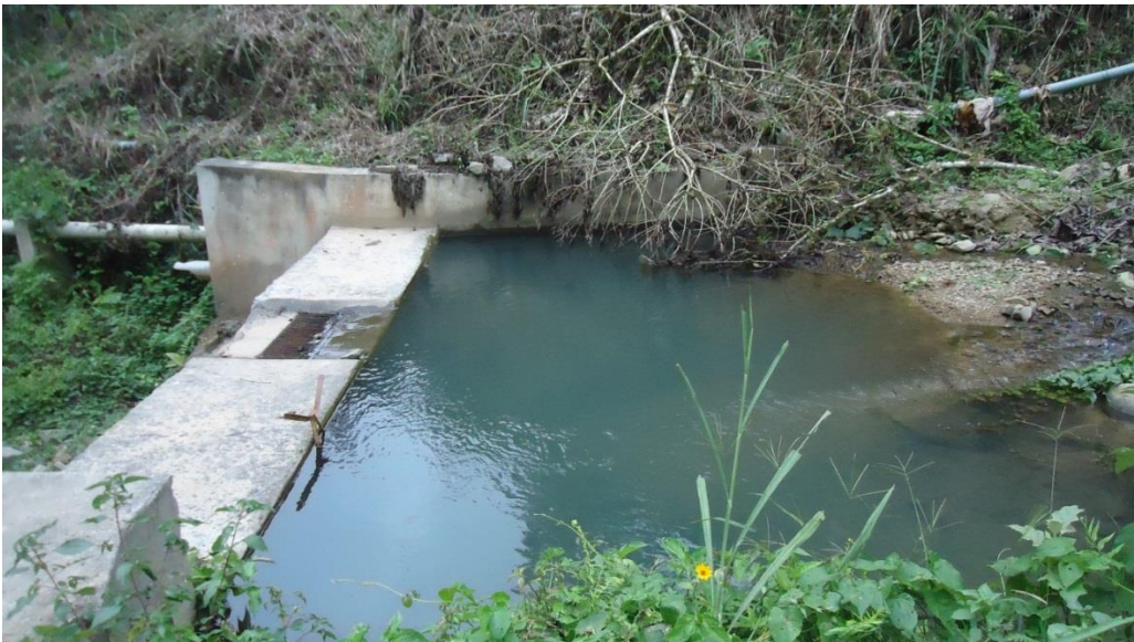
Captación Santa Elena. Verano
