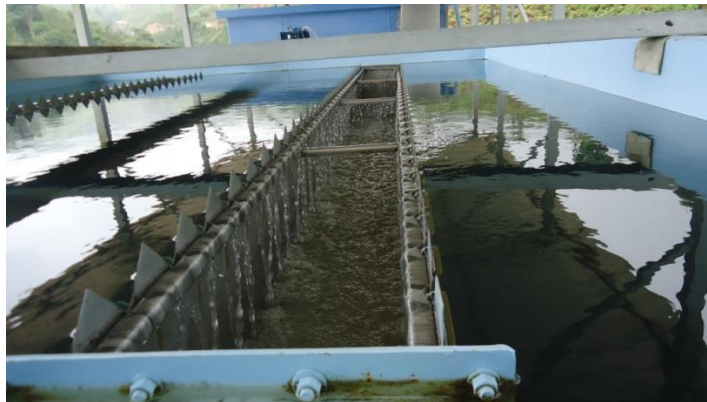
Fotografía 7. Sedimentador sistema Santa Elena Fuente: El autor
