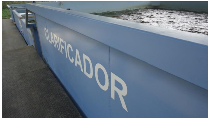
Fotografía 5. Clarificador del sistema de Santa Elena Fuente: El autor
