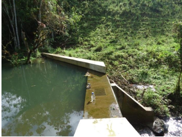
Fotografía 15. Dique quebrada El Milagro Fuente: El autor
