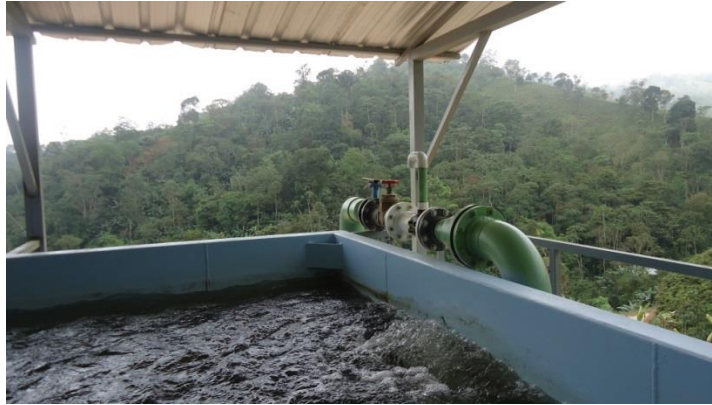
Fotografía 4. Ingreso de agua a la planta de Santa Elena Fuente: El autor
