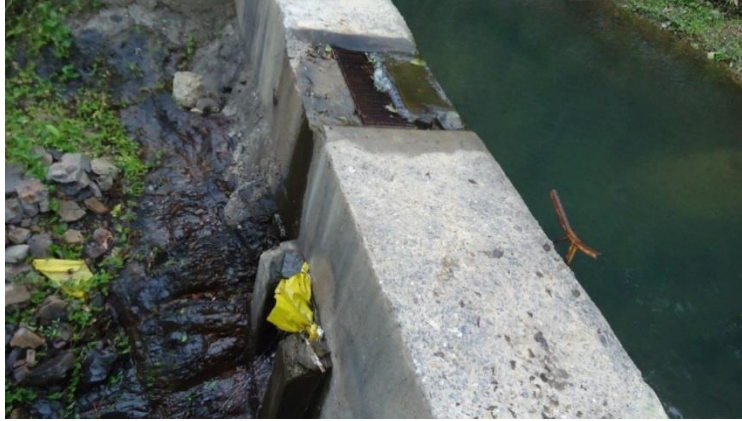
Fotografía 2. Dique Sistema Santa Elena Fuente: El Autor
