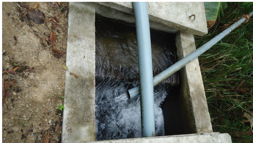
Fotografía 3. Desarenador Santa Elena Fuente. El autor
