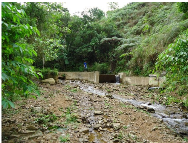
Fotografía 12. Captación Las Acacias Fuente: El autor
