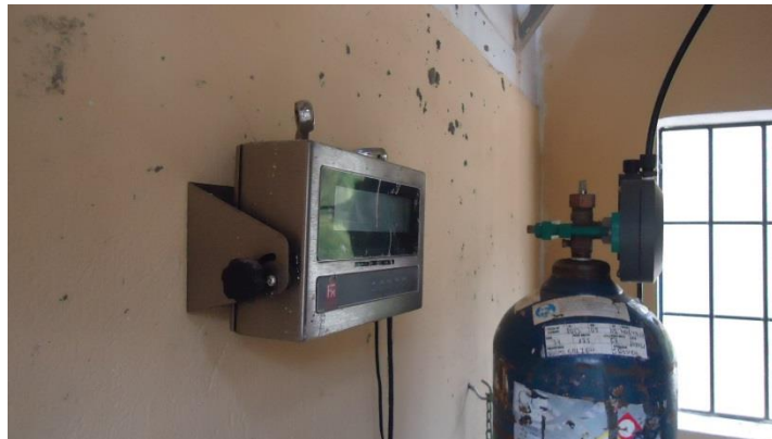
Fotografía 9. Cloración Sistema de Santa Elena Fuente: El autor
