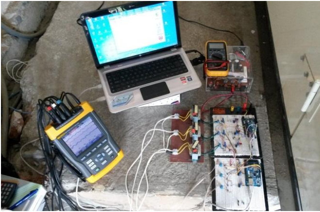
Fig. 9. Instalación de los equipos analizadores. Fotografía del Autor.
