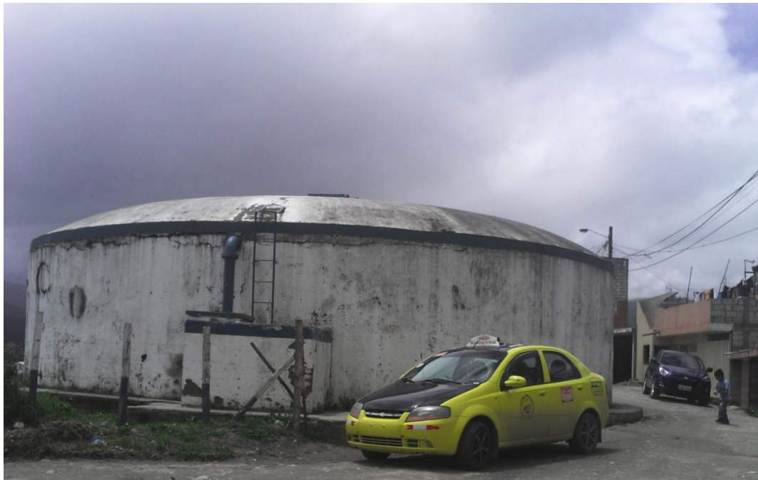
Tanque de agua perteneciente a la zona 15
