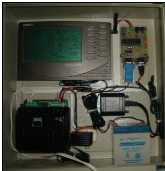
Figura 3.4.- Imagen de la conexión terminada.
