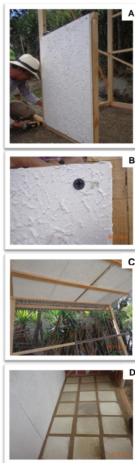
**Fig.5.22** A) Colocación de tableros sobre estructura B) Tornillo autorroscante sobre tablero, C) Colocación de cielo raso, D) Colocación de pisos
