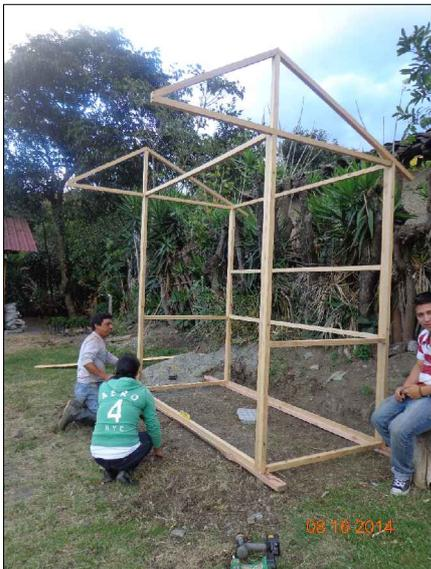
ANLAJE DE MÓDULOS SOBRE PERFILES DE MADERA DISPUESTOS HORIZONTALMENTE.
