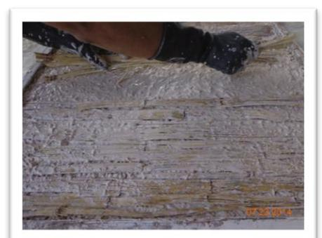
Fig. 5.13 Tablero tipo bastidor con carrizo
