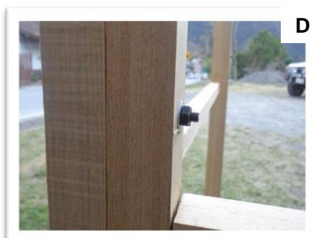
**Fig. 5.21** A) Cepillado de madera, B) Armado de piezas, C) Armado de estructura en obra, D) Fijación de estructura con tornillos autorroscables.
