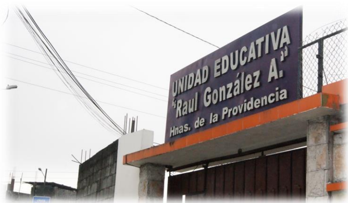
FACHADA DE LA INSTITUCIÓN
