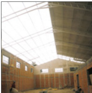
Cubierta de eternit
