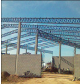
Estructura metálica de la fábrica
