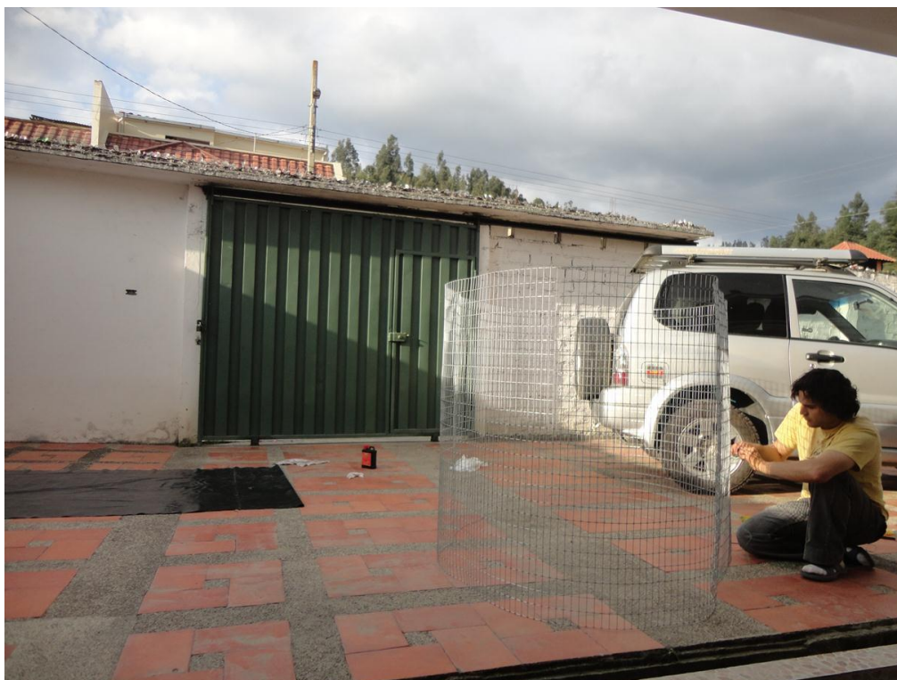
Imagen 55: Construcción de tanque de geomembrana (Autor)
