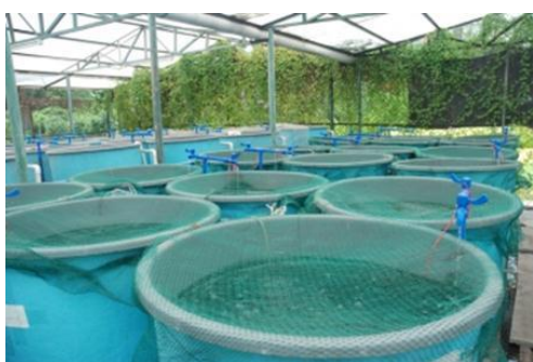
Figura 6: Sistema de acuicultura recirculante en interiores. Fuente: AQUA (2014).
