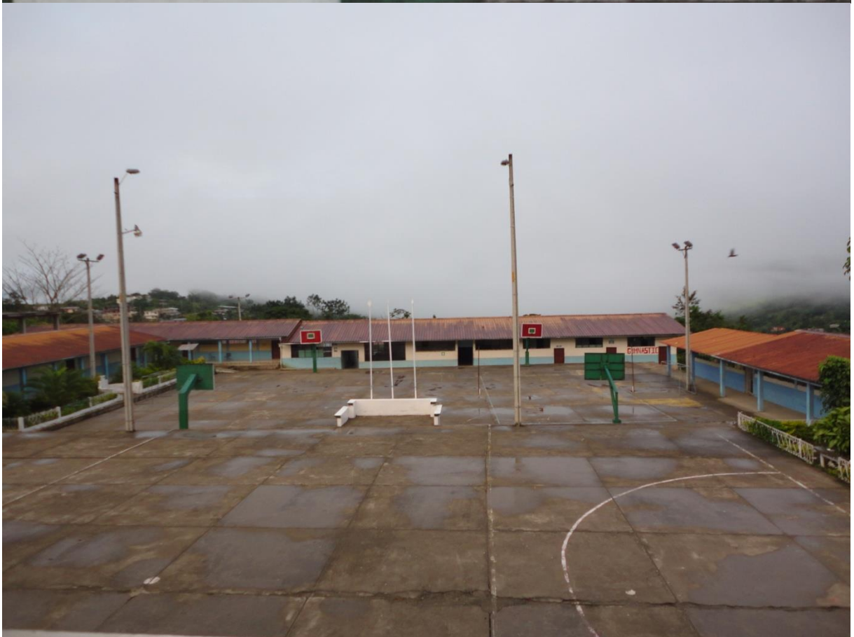
BLOQUE ADMINISTRATIVO Y BLOQUES DE AULAS DE LA UNIDAD EDUCATIVA "ZUMBA"
