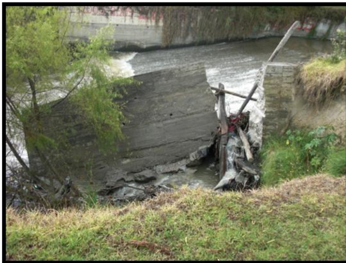
Figura N°17. Muro de hormigón del río.
