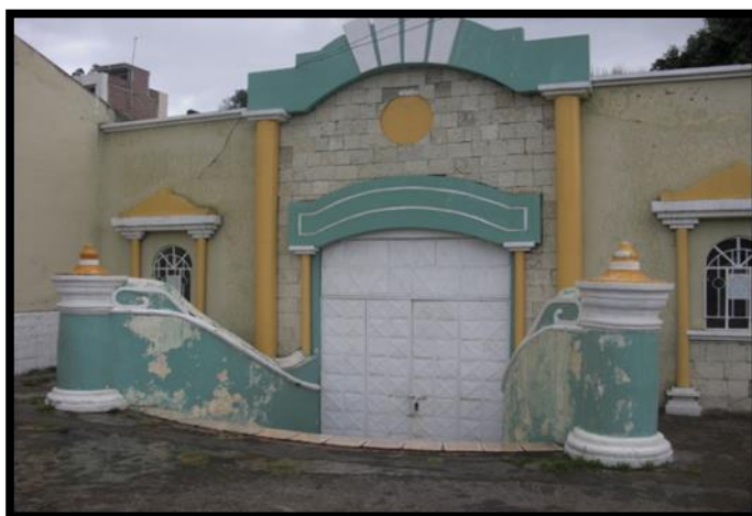
Figura N°24. Fachada de la casa de baños de aguas sulfurosas. El autor.
