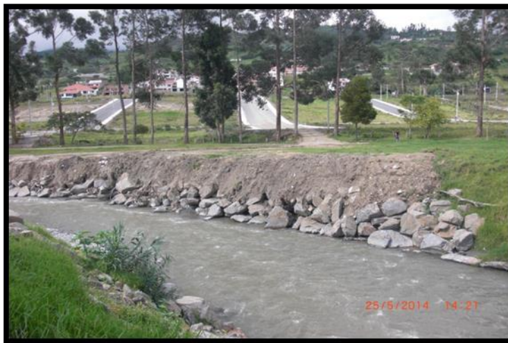
Figura N°50. Protección de los márgenes del río.
