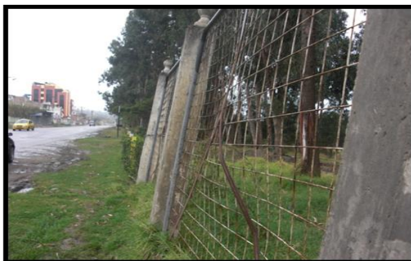
Figura N°12. Cerramiento y acera Av. 8 de Diciembre.
