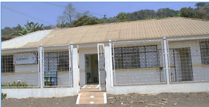
Foto 51: Puesto de Salud Cruzpamba.
