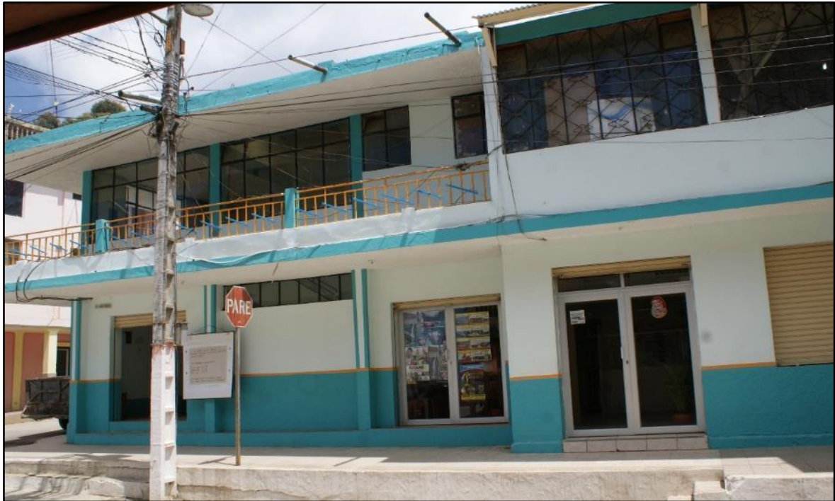
Foto 1: Edificio del GAD Municipal de Celica.
