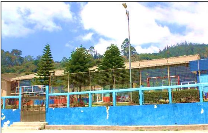
Foto 45: Piscina Municipal de Celica.
