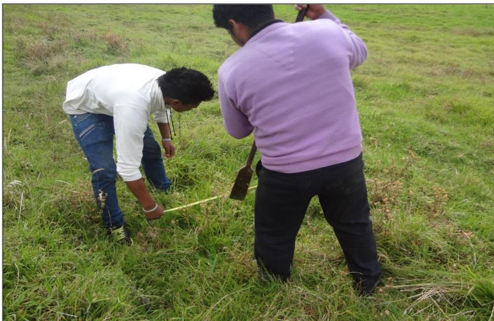
**Fotografía 5.2.** Replanteo para la excavación manual de la calicata.
