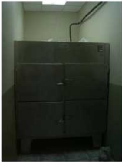
Cuarto de frigorifico
