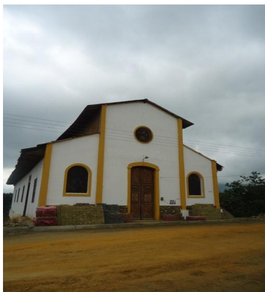
Figura 2.25. Iglesia y Convento de Cruzpamba.
