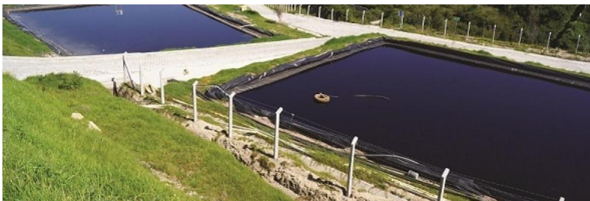
Figura No. 20: Piscinas del sistema de drenaje de lixiviados.
