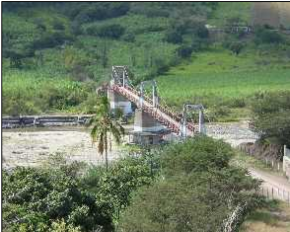
Fotografía 28. Puente del CREA
