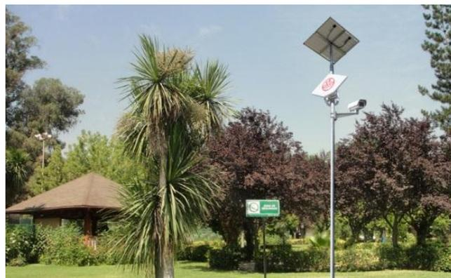
Figura 0.5. Sistema de video vigilancia inalámbrica energizada con paneles solares, Chile
