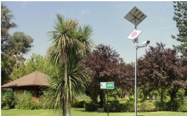
**Fig.11.** Sistema de video vigilancia inalámbrica energizada con paneles solares, Chile [7].
