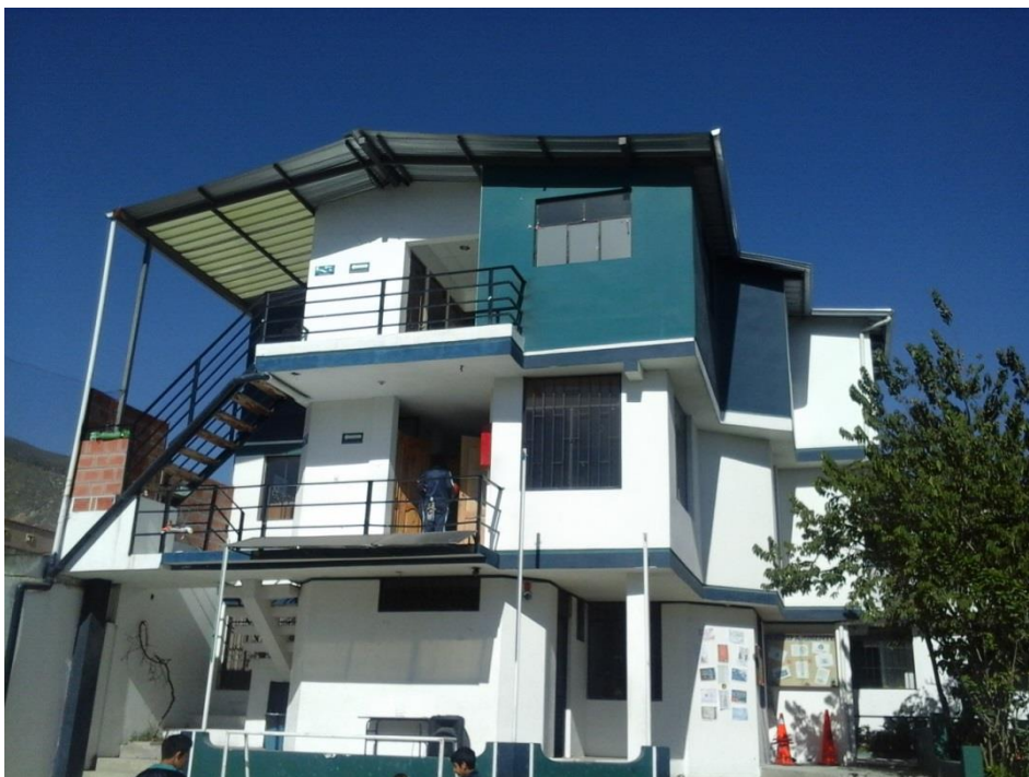
Vista lateral – Colegio Particular "Misión Geodésica"
