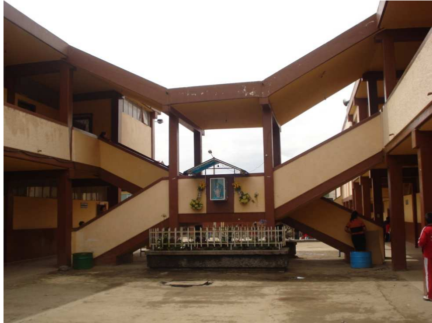
Foto 1. Vista del acceso al pabellón central de la Escuela Aurelio Aguilar Vázquez.
