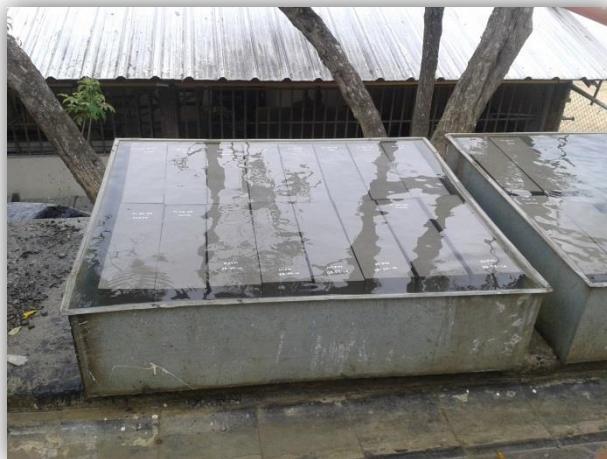
Fotografía 8.6. Curado de vigas.
