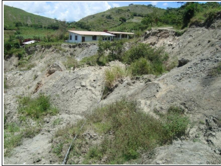
Foto No. 2: Deslizamiento Activo, localizado en el Barrio San Francisco Alto junto a la Escuela Manuel Figueroa (X= 693766, Y= 9537324)
