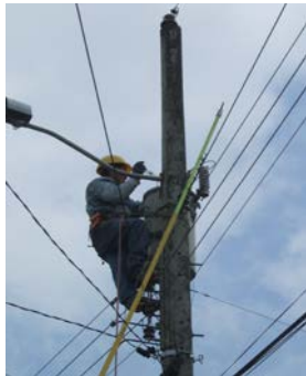
Extracción de la muestra de aceite del transformador
