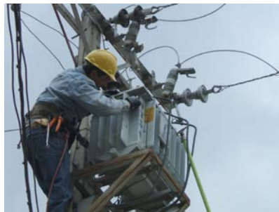
Foto 2. Toma de muestras de aceite en transformadores conectados.
