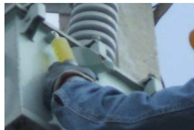
Foto 5. Extracción del aceite dieléctrico a través de la válvula de sobrepresión
