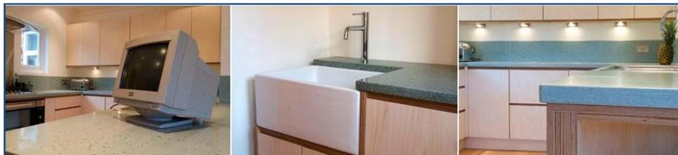
Fig. V.9 Vidrio reciclado de TRC en mostrador y lavabo de cocina<sup>11</sup>
