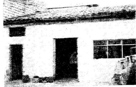
Foto - Vista de la Construcción C2
