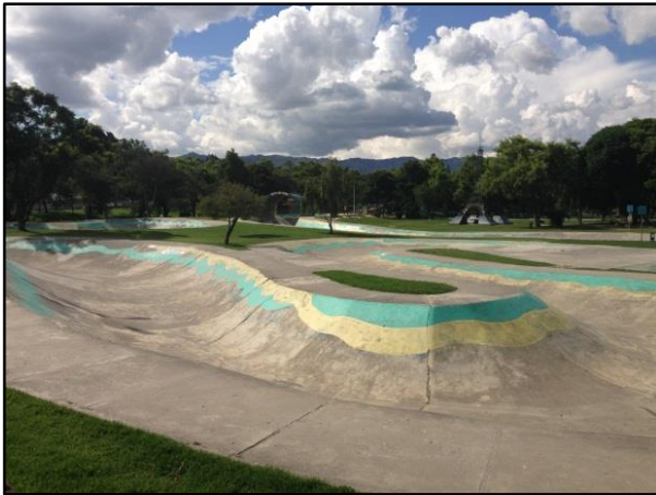
Fig. 4. Panorámica de la pista de bicicletas, clasificada como zona de alta radiación. Fotografía de los autores.
