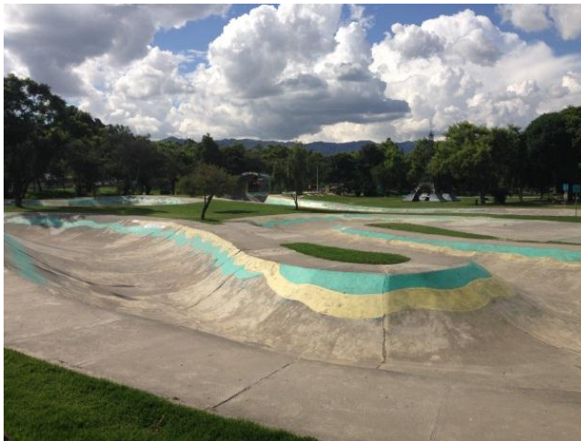
Figura 2.3. Panorámica de la pista de bicicletas, clasificada como zona de alta radiación. Fotografía de los autores.
