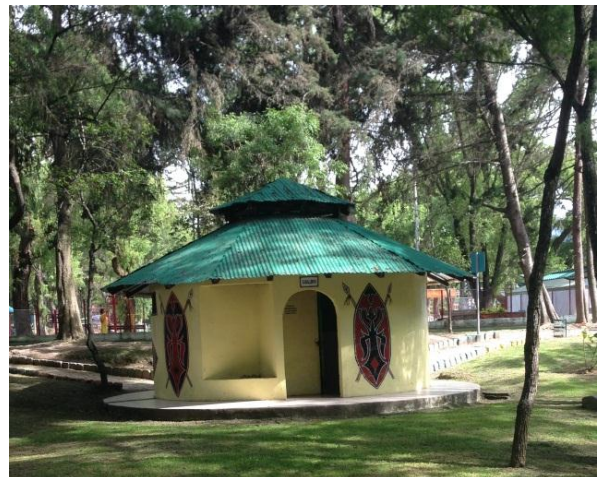
Fig 16. Panorámica de una de las baterías sanitarias repartidas en el territorio del PRJ. Fotografía de los autores.
