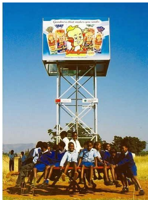
Figura. 3.9. Sistema de bombeo de agua que utiliza la bomba play-pump
