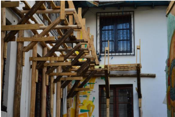
Figura 86. Detalle de la estructura realizada Fuente: www.facebook.com/conloquehay
