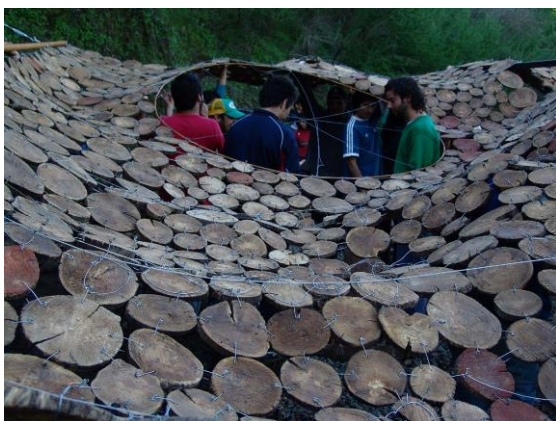
Figura 69. Estudiantes de arquitectura realizando un proyecto para una comunidad
