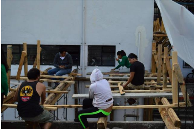
Figura 82. Construcción del proyecto Fuente: www.facebook.com/conloquehay
