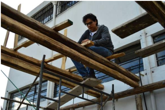
Figura 84. Alumno realizando la construcción. Fuente: www.facebook.com/conloquehay
