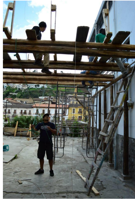
Figura 83. Construcción del proyecto Fuente: www.facebook.com/conloquehay
