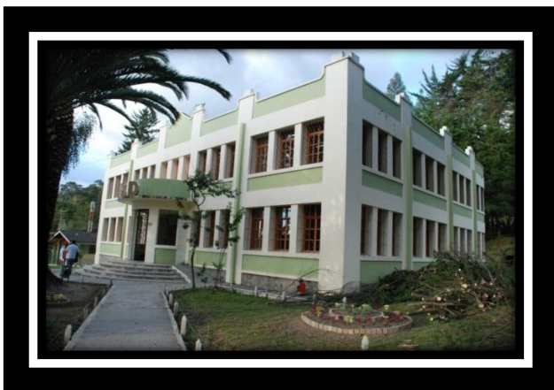
Ilustración 1. Edificio de la MED - Loja
