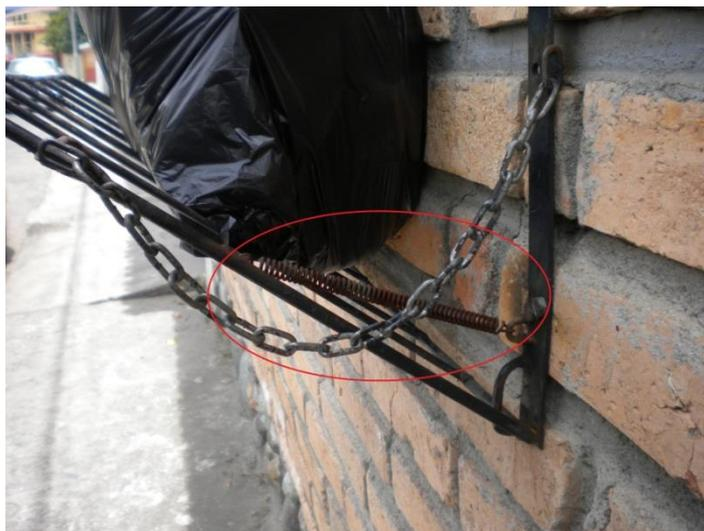
**Figura 12.** Sistema de plegado automático en parrillas de almacenamiento.
