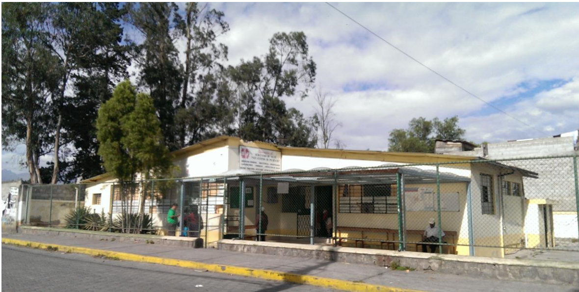
Fig. 4. Instalaciones del Centro de salud de San Antonio de Pichincha año 2015. Fuente: Autora, año 2015.
