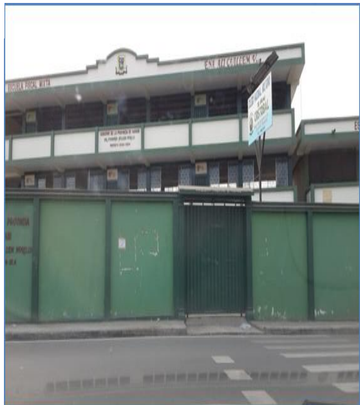
Edificio del Colegio Nacional Mixto Nocturno San Cristóbal
