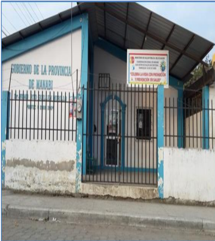
Fachada principal del S.C.S. San Cristóbal
