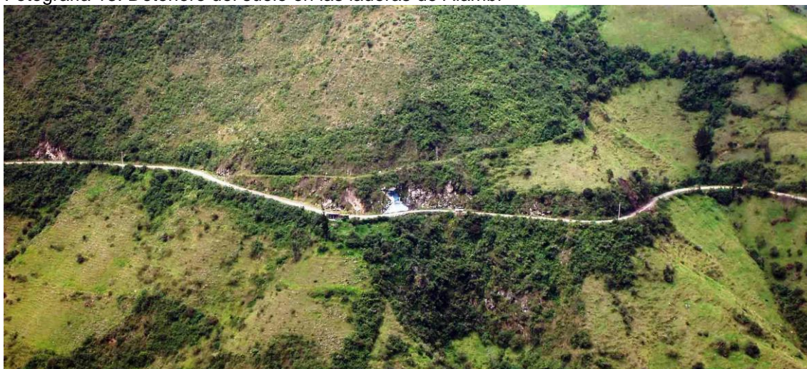
Fotografía 13: Deterioro del suelo en las laderas de Alambi
