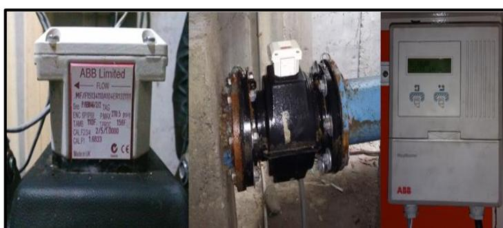
Figura 3.- Equipo de Caudalímetro Electromagnético.
