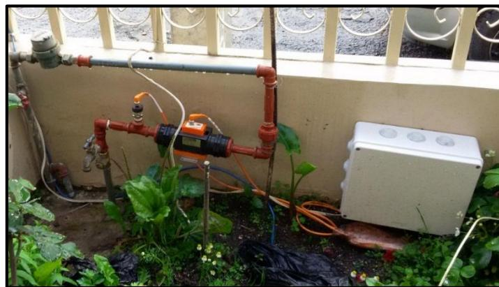
Figura 6.- Instalación de Caudalímetro y Estación Remota.
