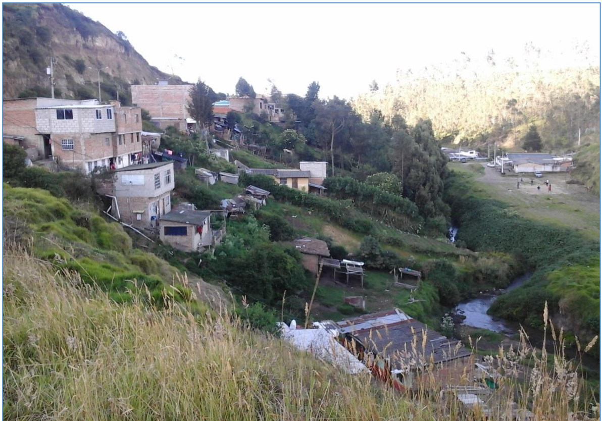
Foto 12. Viviendas a lo largo de las riberas del río Tajamar
