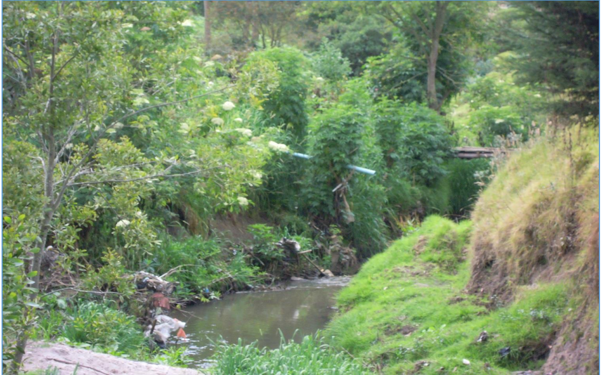
Foto 5. Descargas de aguas residuales, barrio centenario
