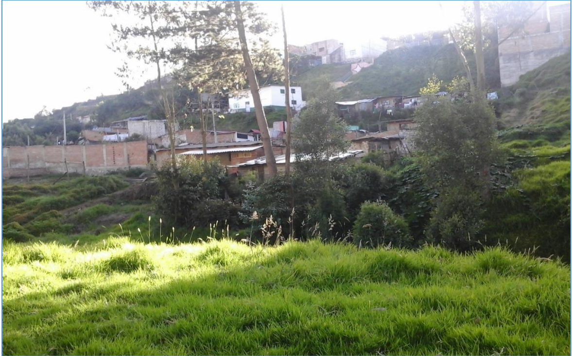
Foto 11. Viviendas a la largo de las riberas del río Tajamar
