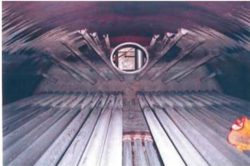
Figura 5. Presencia de arrastres en el interior de caldera. Fuente: (Comunidad de Madrid, 2013).
