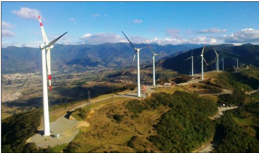
Figura 2.1. Parque Eólico Villonaco.
