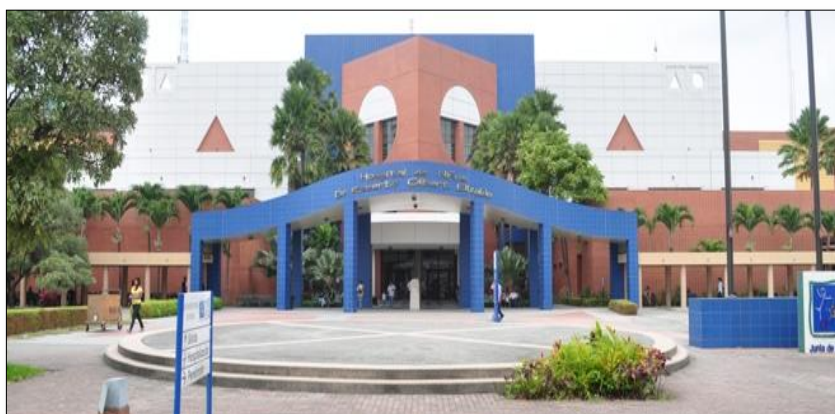
Figura 1. Vista frontal del Hospital Dr. Roberto Gilbert Elizalde Fuente: http://congresohrg.org.ec/ubicacion.html
