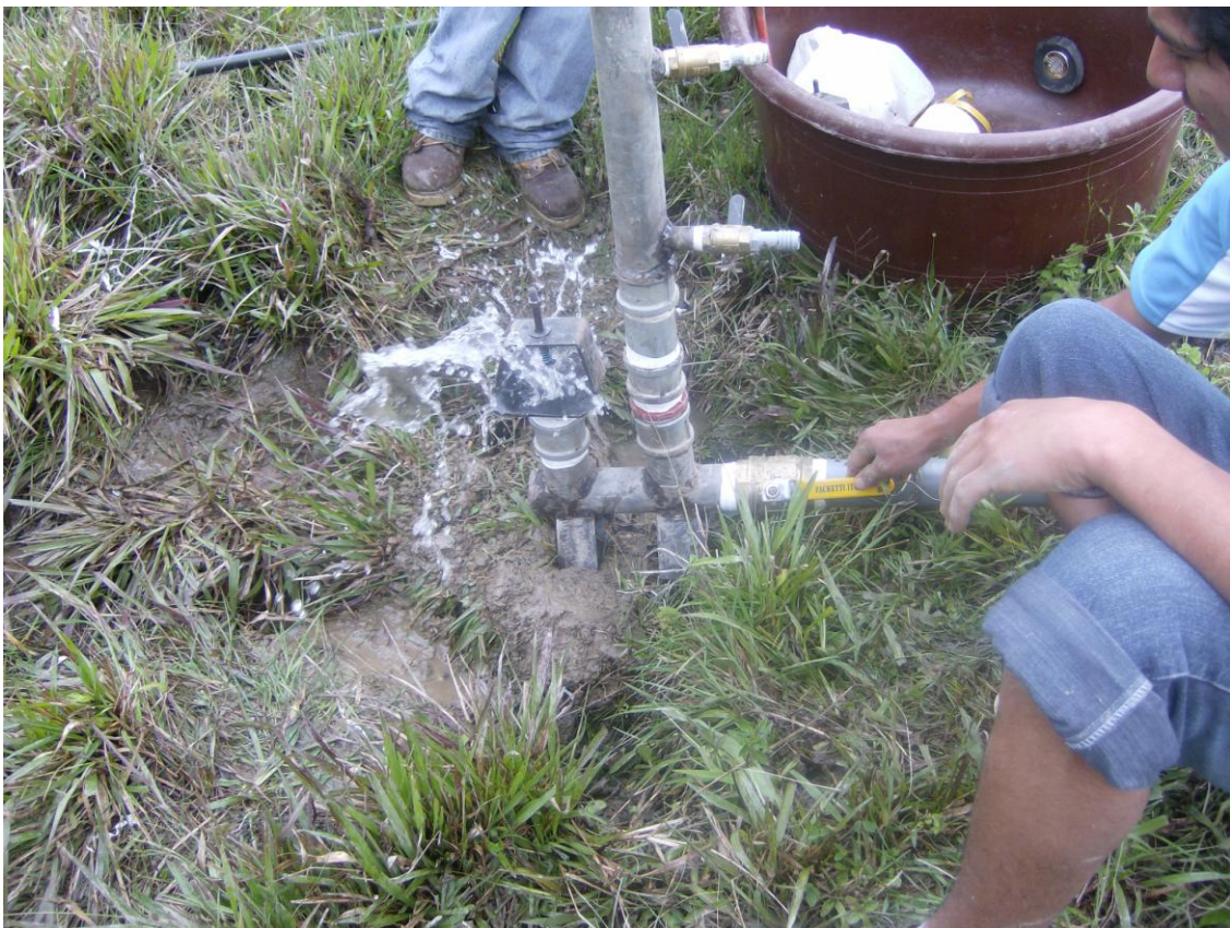
FOTO 7. Instalación y pruebas en campo
