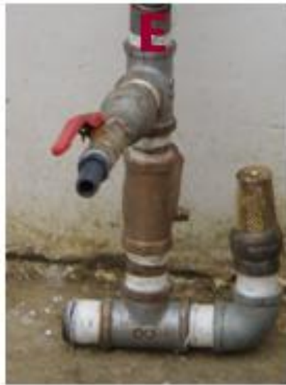
FOTO 4-2. Ariete de doble cámara armado hasta la sección 4
