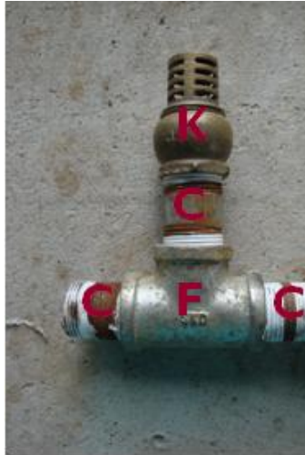
FOTO 16. Armado de la válvula de derrame
