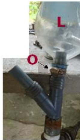
FOTO 4-4. Armado de la doble cámara de aire. Parte 2
