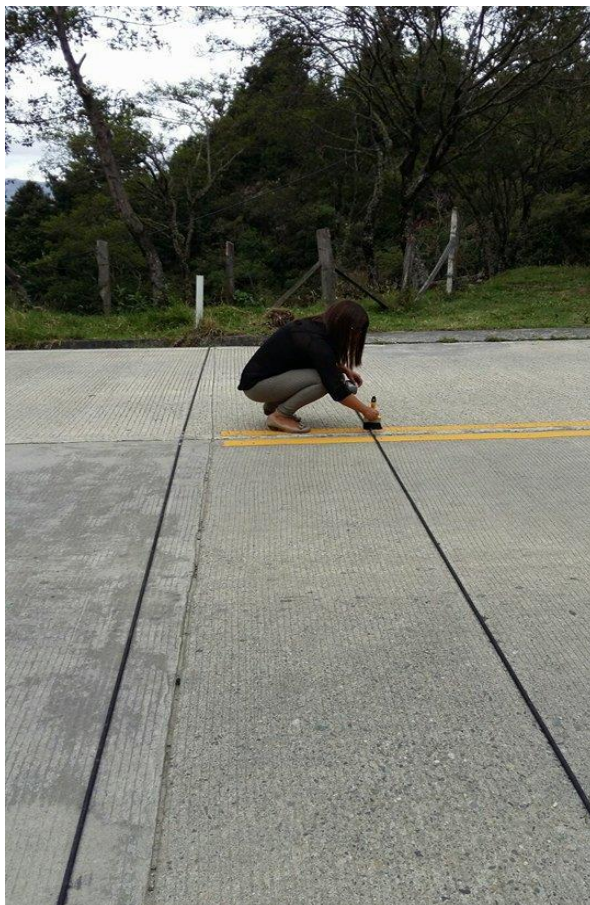
Fotografía 5. Limpieza de la zona de la calzada donde se colocaron las cintas asfálticas
