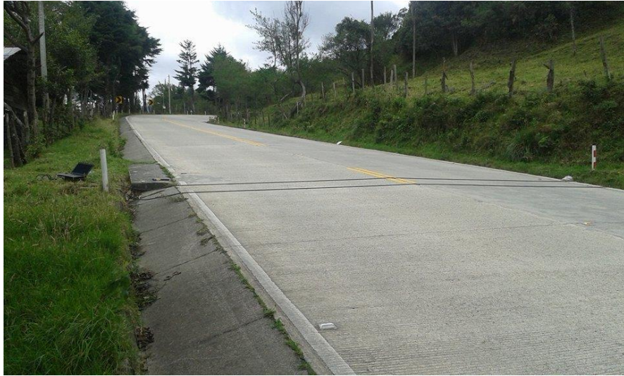
Fotografía 1. Instalación del equipo MetroCount 5600 en la vía Loja-Zamora
