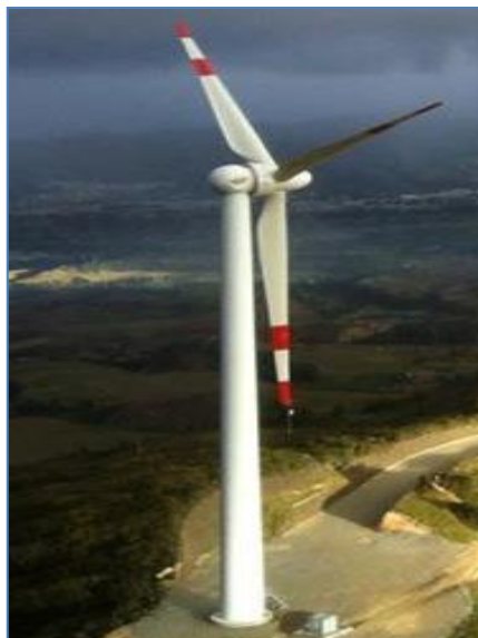
Fig. 2.4 Aerogenerador GW70/1500 montado en torre en la CEV Fuente: (CELEC EP GENSUR, 2014)
