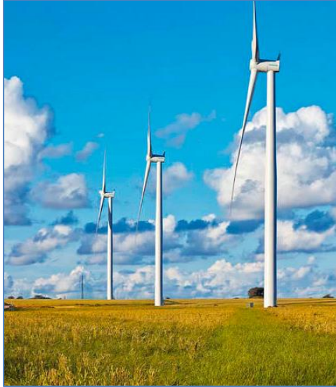
Fig. 1.2 Parque Eólico onshore. Fuente: (Direct Industry, 2012)
