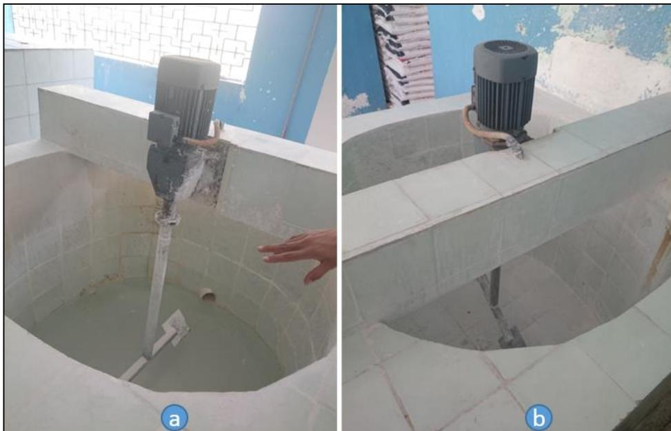
Figura 2.8 Contenedores para la disolución de químicos, a) sulfato de aluminio b) cal.
