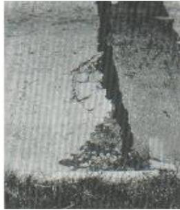
Fig. C.21-a Blow up – Buckling severidad baja
