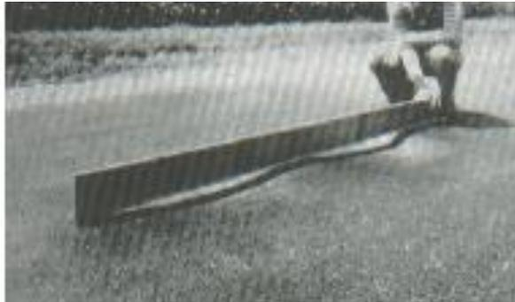
**Fig. C.5-c** Corrugación severidad alta
