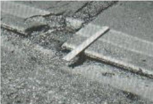
Fig. C.27-a Desnivel/carril berma severidad baja
