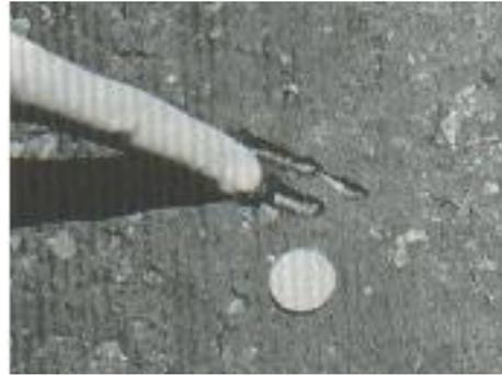
**Fig. C.2-b** Exudación severidad media
