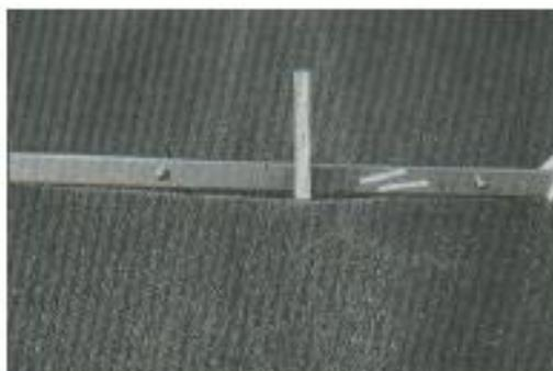
**Fig. C.15-a** Ahuellamiento severidad baja
