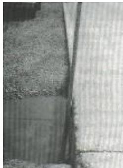
Fig. C.27-c Desnivel/carril berma severidad alta
