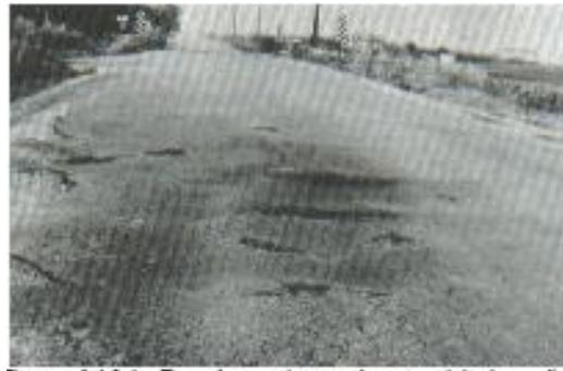
Fig. C.16-b Desplazamiento severidad media
