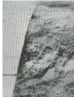
Fig. C.27-b Desnivel/carril berma severidad media
