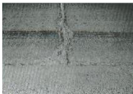
**Fig. C.38-b** Descascamiento de esquina de severidad media
