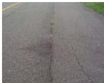
**Fig. C.10-b** Longitudinal y transversal severidad media
