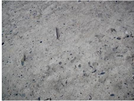
**Fig. C.31-a** Pulimiento de agregados.
