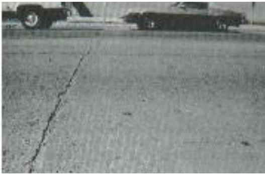
**Fig. C.39-a** Descascaramiento de junta de severidad baja
