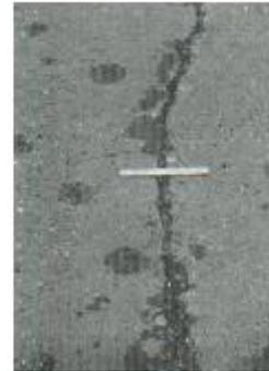
**Fig. C.28-b** Grietas lineales severidad media en losas de concreto reforzado
