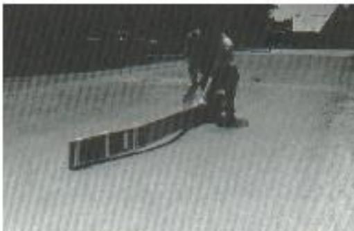
Fig. C.16-a Desplazamiento severidad baja
