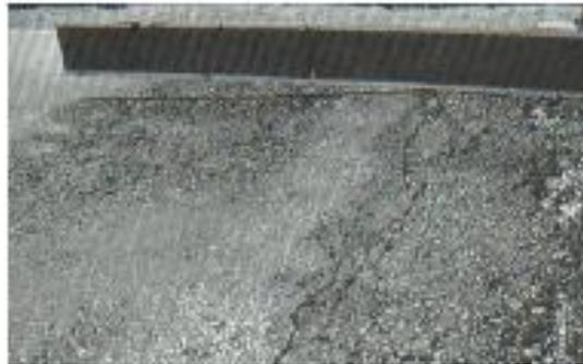
**Fig. C.4-c** Abultamientos severidad alta
