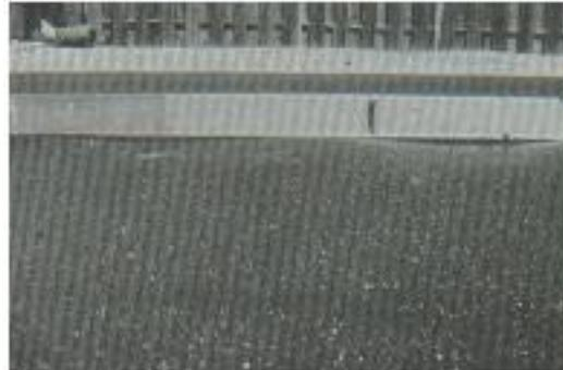
**Fig. C.5-b** Corrugación severidad media
