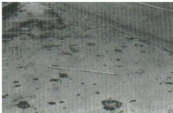
**Fig. C.3-a** Popouts severidad baja
