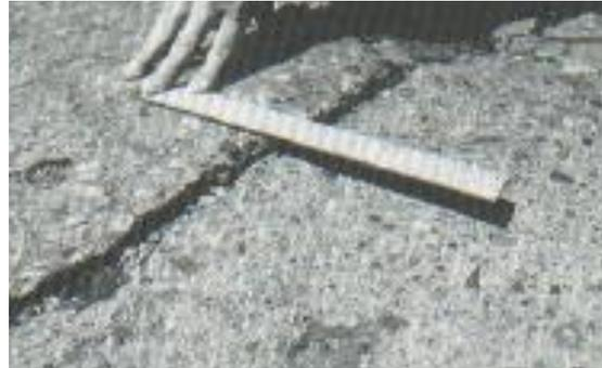
Fig. C.25-b Escala severidad media
