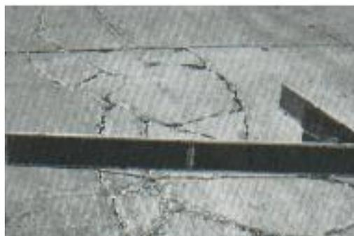
**Fig. C.34-c** Punzonamiento de severidad alta
