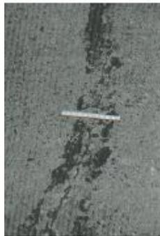
**Fig. C.28-a** Grietas Lineales severidad baja en losa de concreto simple
