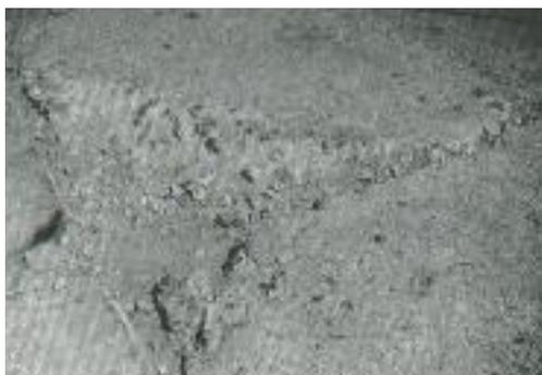
Fig. C.38-c Descascaramiento de esquina de severidad alta
