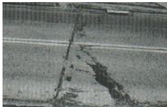
**Fig. C.34-b** Punzonamiento de severidad media
