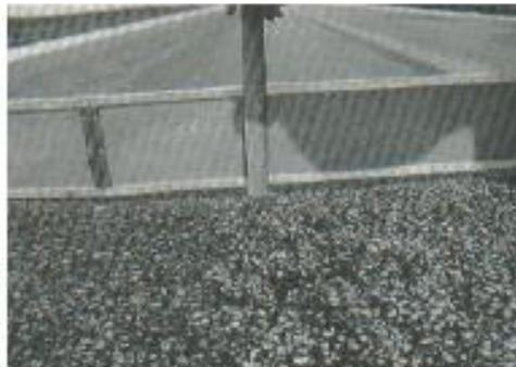
**Fig. C.15-b** Ahuellamiento severidad media
