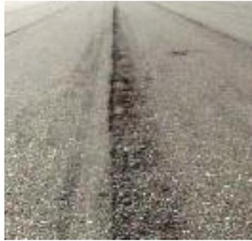
**Fig. C.10-c** Longitudinal y transversal severidad alta
