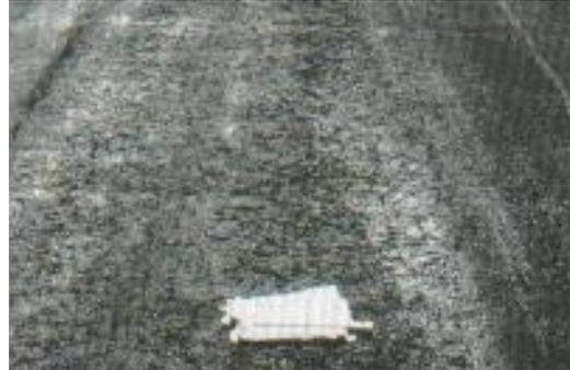
**Fig. C.19-b** Meteorización/desprendimiento de agregados severidad media
