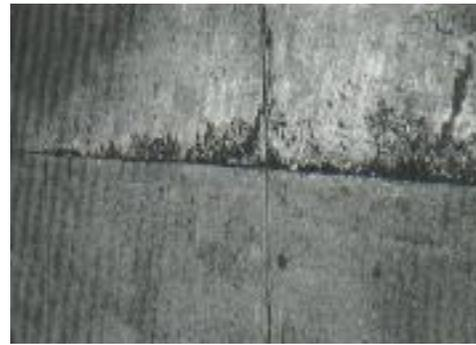
**Fig. C.39-b** Descascaramiento de junta de severidad media
