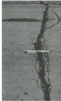
**Fig. C.8-c** Grieta de junta severidad alta
