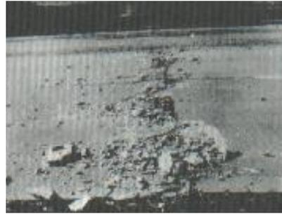
Fig. C.21-b Blow up – Buckling severidad media
