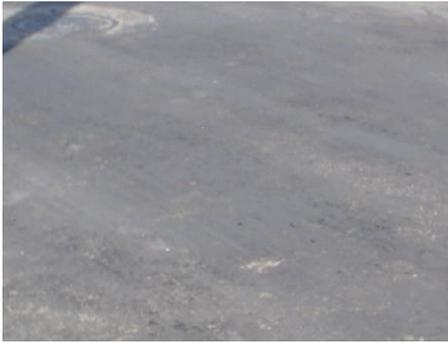
**Fig. C.2-a** Exudación severidad baja
