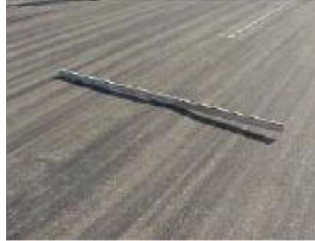
**Fig. C.4-b** Abultamientos severidad media
