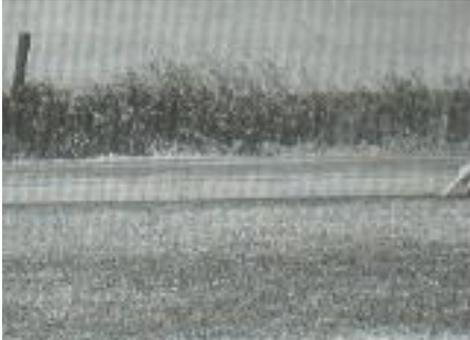
**Fig. C.5-a** Corrugación severidad baja
