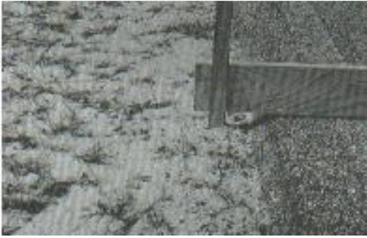
**Fig. C.9-a** Desnivel carril / berma severidad baja
