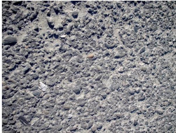
Fig. C.12-a Pulimento de agregados.
