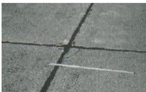
**Fig. C.38-a** Descascamiento de esquina de severidad baja
