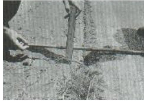
**Fig. C.9-b** Desnivel carril / berma severidad media
