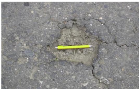
**Fig. C.13-a** Huecos severidad baja
