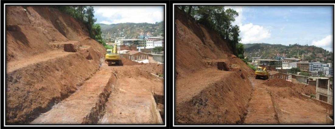
FOTO 8 Y 9.- CONSTRUCCIÓN DE TERRAZAS EN EL TALUD
