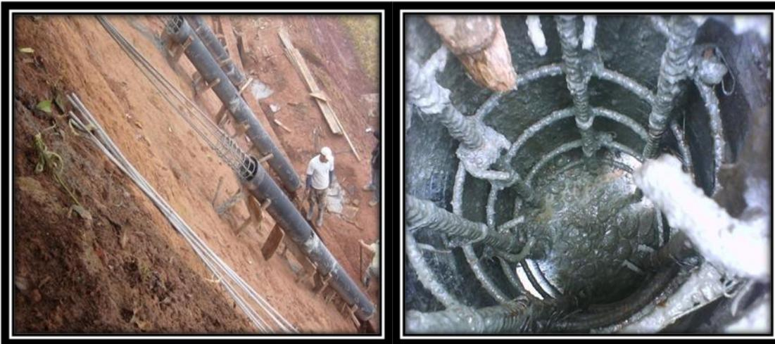
FOTO 24 Y 25.- ARMADO Y FUNDICIÓN DE COLUMNAS
