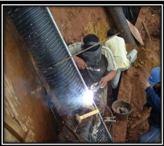
**FOTO 30 Y 31.- COLOCACIÓN DE TUBO GALVANIZADO**
