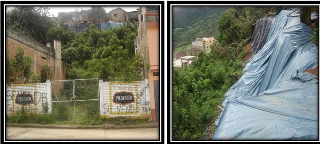
FOTO 2 Y 3.- RECUBRIMIENTO DE LA PARTE ALTA DEL TALUD
