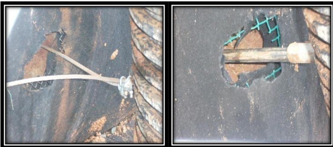
**FOTO 34 Y 35.- PERFORACIÓN Y COLOCACIÓN DE ANCLAJES**
