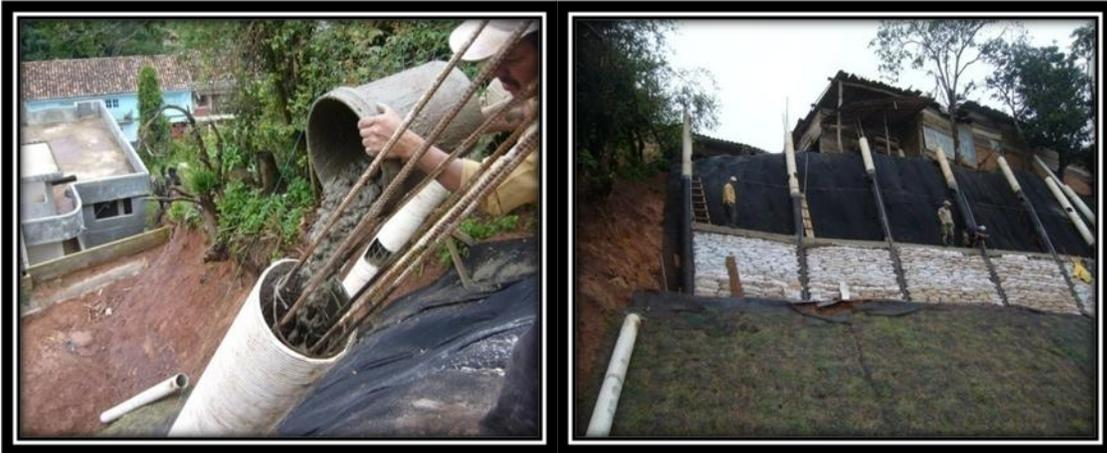
FOTO 45 Y 46.- ARMADO Y FUNDICIÓN DE COLUMNAS SEGUNDO NIVEL
