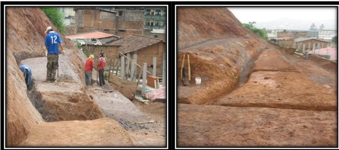
FOTO 10 Y 11.- ELABORACIÓN DE CANALES PARA EVACUAR EL AGUA
