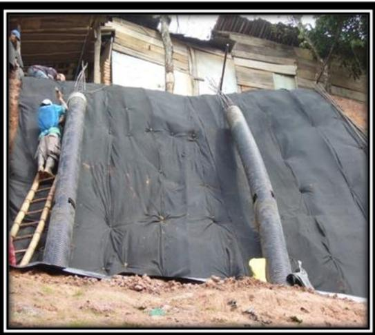
FOTO 26, 27, 28 Y 29.- COLOCACIÓN DE LA GEOMANTA Y GEOMALLA EN LA SUPERFICIE DEL TALUD
