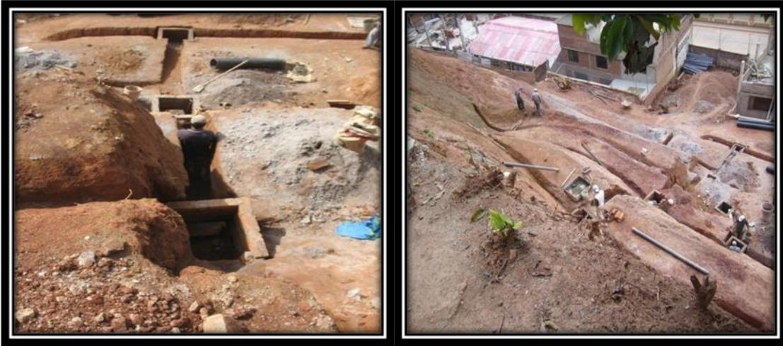
FOTO 12 Y 13.- CONSTRUCCIÓN DE POZOS DE REVISIÓN PARA EVACUAR AGUAS FILTRANTES
