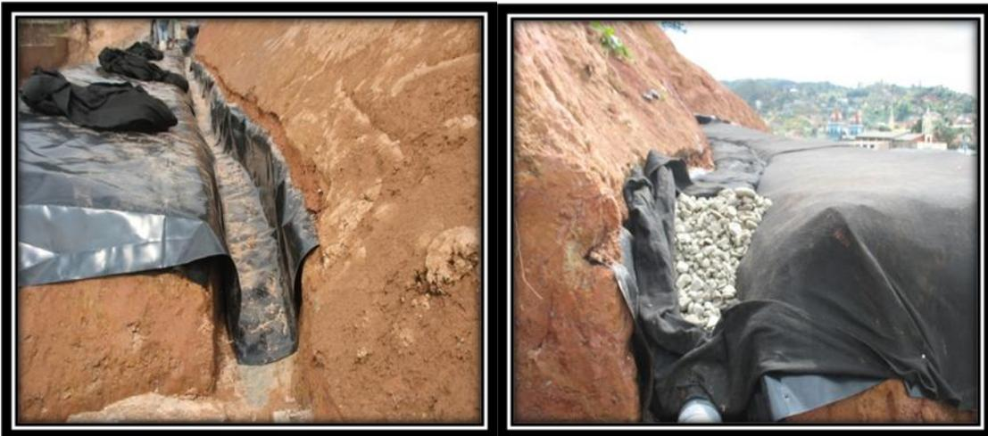
FOTO 14 Y 15.- ELABORACIÓN DE DRENAJES PARA EVACUAR AGUAS FILTRANTES
