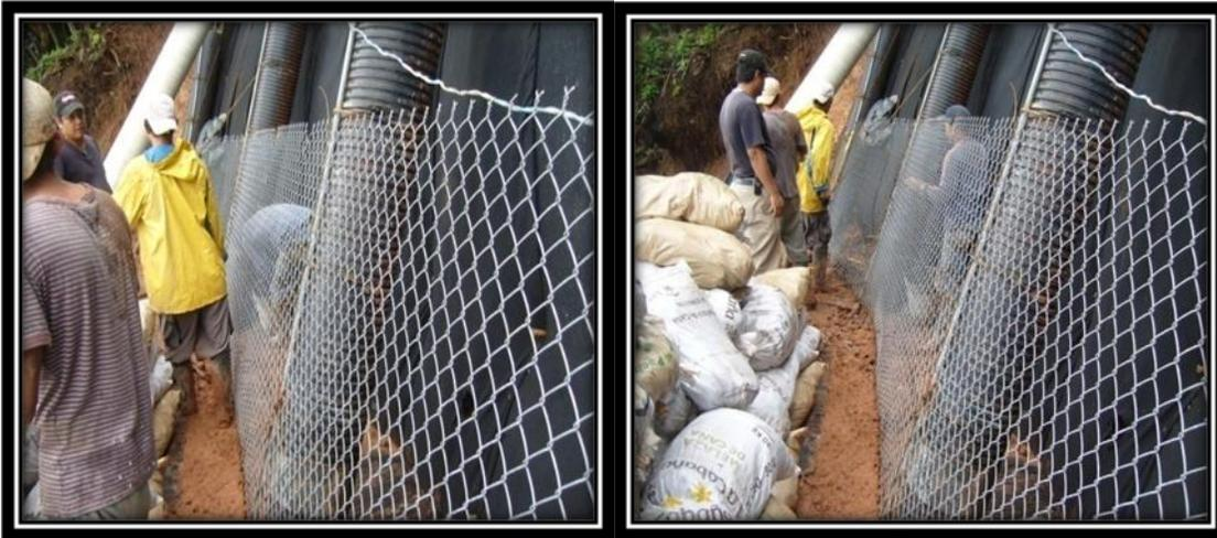
**FOTO 32 Y 33.- COLOCACIÓN DE MALLA ELECTROSOLDADA**
