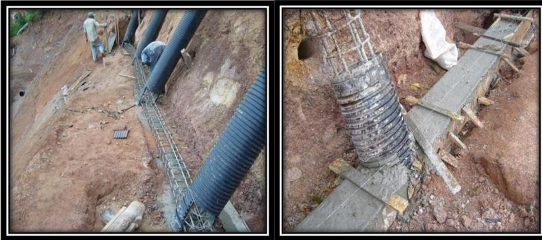
FOTO 22 Y 23.- ARMADO Y FUNDICIÓN DE CADENAS
