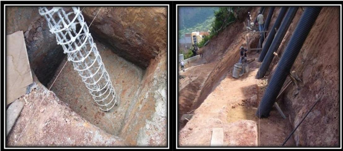
FOTO 20 Y 21.- FUNDICIÓN DE PLINTOS
