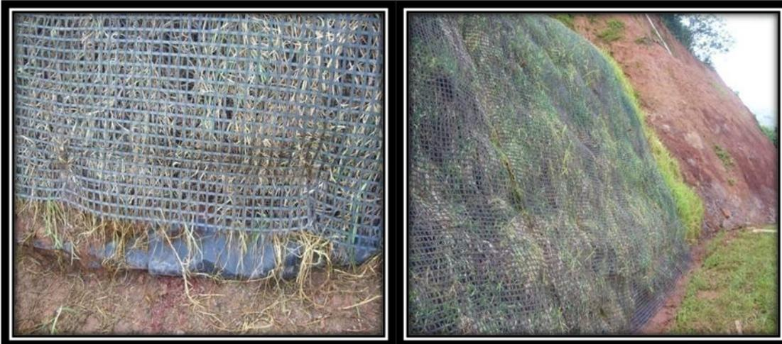
FOTO 41 Y 42.- COLOCACIÓN DE GEOMALLA PARA REFUERZO DE BERMAS
