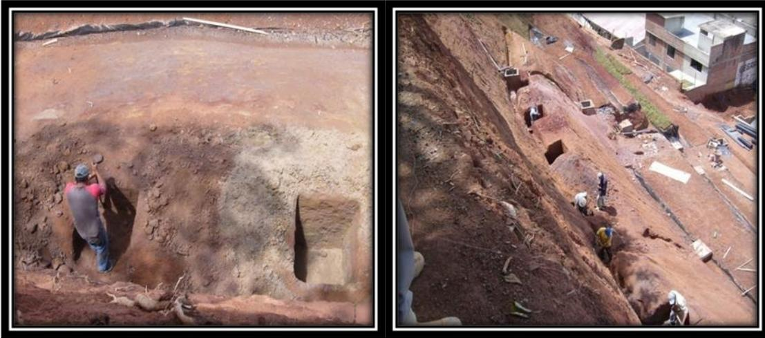
FOTO 18 Y 19.- EXCAVACIÓN PARA PLINTOS
