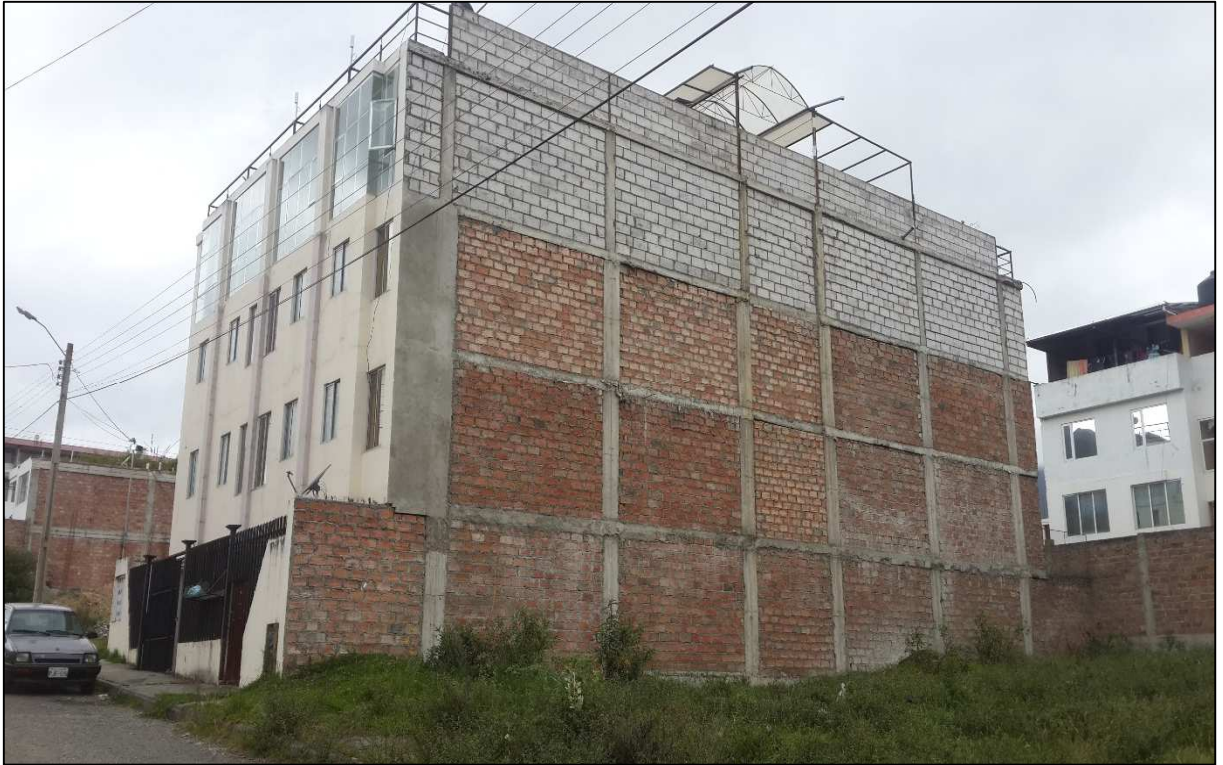
Figura 79. Edificación de uso residencial – Categoría 4, ejemplo # 1 Fuente y Elaboración: El autor
