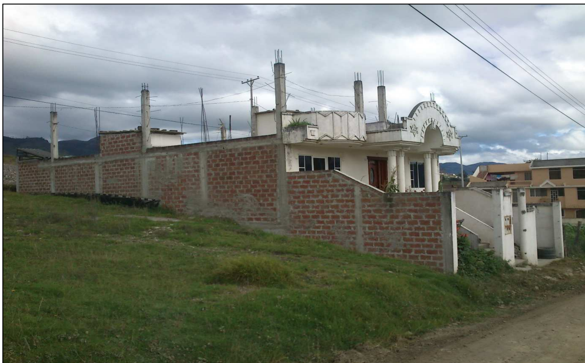
Figura 73. Edificación de uso residencial – Categoría 1, ejemplo # 1 Fuente y Elaboración: El autor
