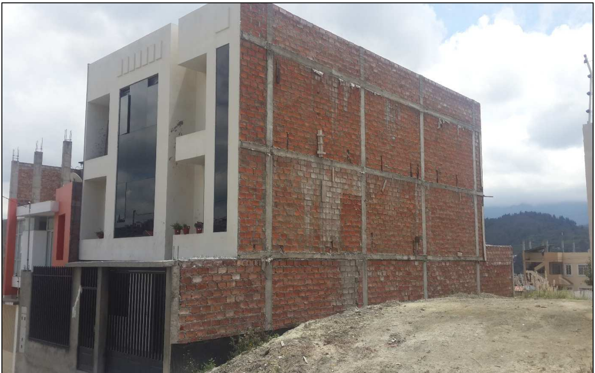
Figura 78. Edificación de uso residencial – Categoría 3, ejemplo # 2 Fuente y Elaboración: El autor
