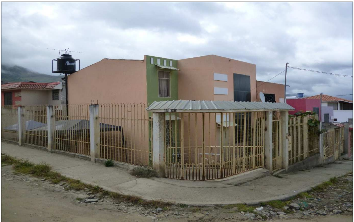
Figura 76. Edificación de uso residencial – Categoría 2, ejemplo # 2 Fuente y Elaboración: El autor
