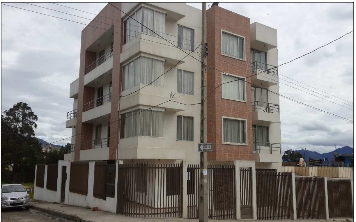
Figura 80. Edificación de uso residencial – Categoría 4, ejemplo # 2 Fuente y Elaboración: El autor
