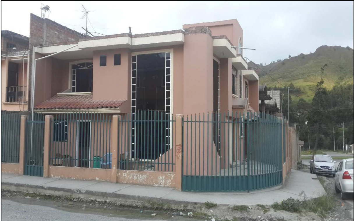
Figura 75. Edificación de uso residencial – Categoría 2, ejemplo # 1 Fuente y Elaboración: El autor
