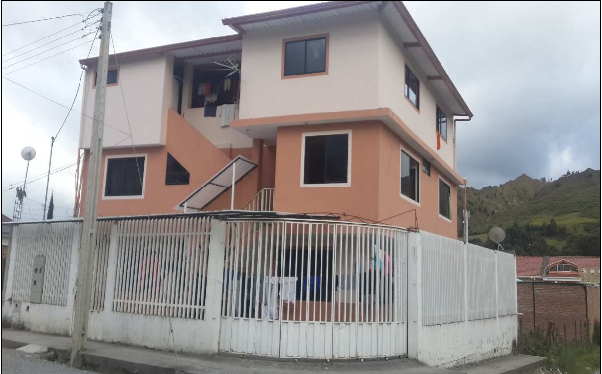
Figura 77. Edificación de uso residencial – Categoría 3, ejemplo # 1 Fuente y Elaboración: El autor
