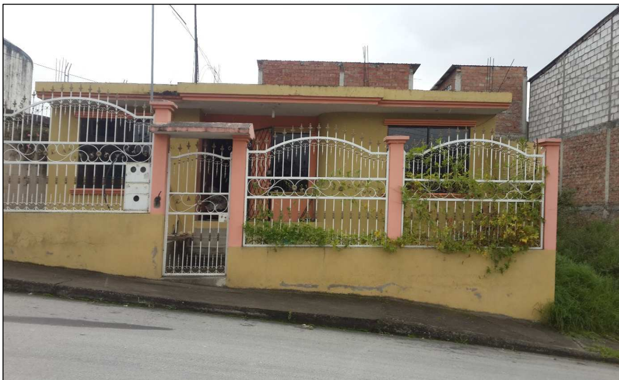
Figura 74. Edificación de uso residencial – Categoría 1, ejemplo # 2 Fuente y Elaboración: El autor
