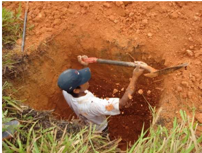
Foto 3. Apertura de calicatas
