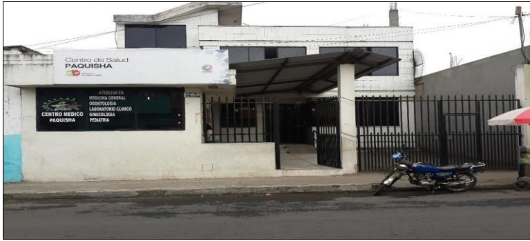
Figura N° 4. Sub-centro de salud Paquisha.
