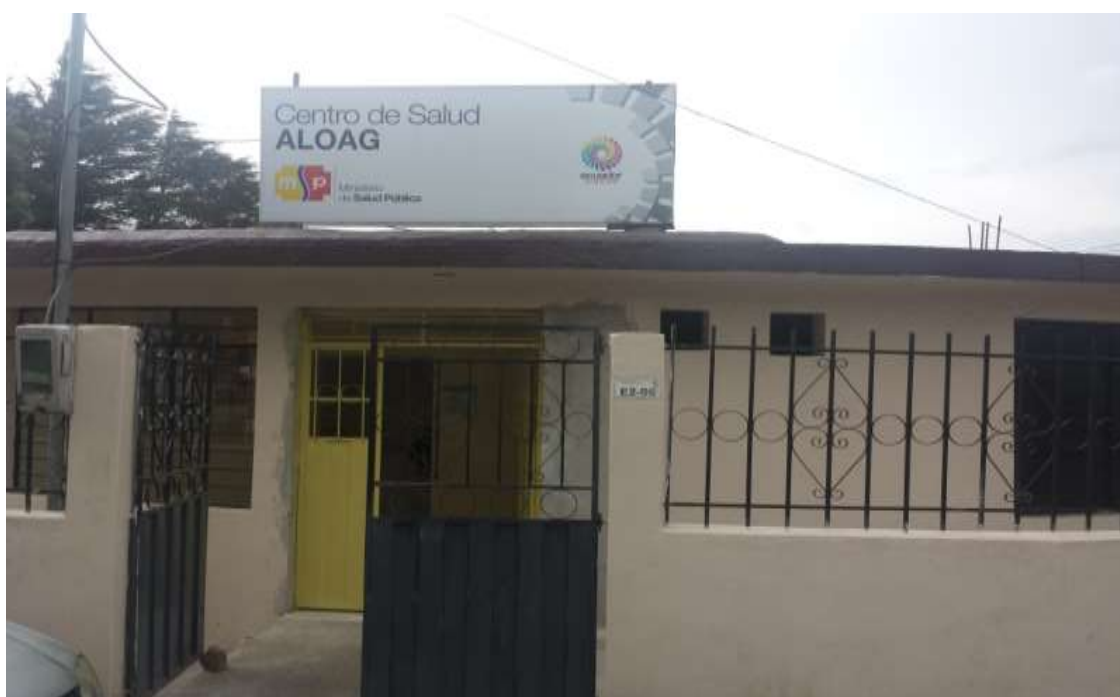
Figura N°1. Centro de Salud de Aloag.
