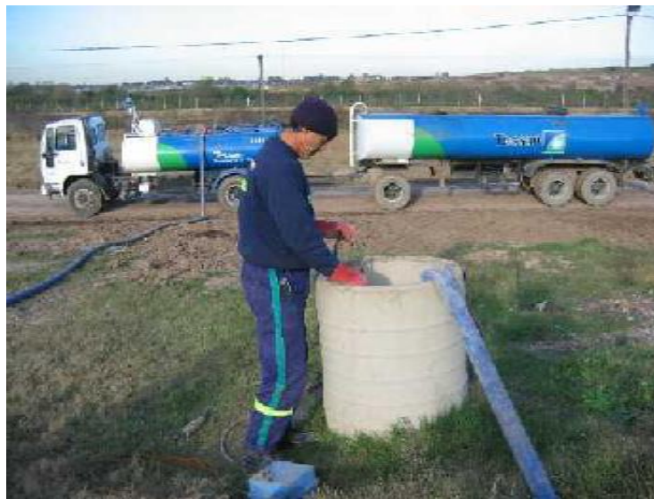
Figura No 7. Captación y Transporte de los Líquidos Lixiviados en Forma Manual
