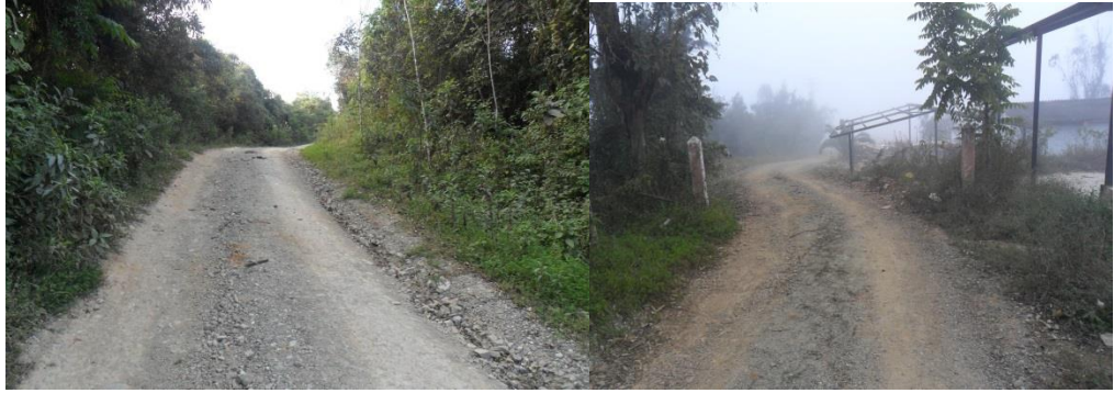
Figura No 33-34. Vías de acceso al relleno sanitario
