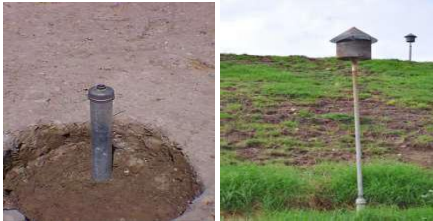
Figura No 44, 45. Construcción de chimeneas de gas
