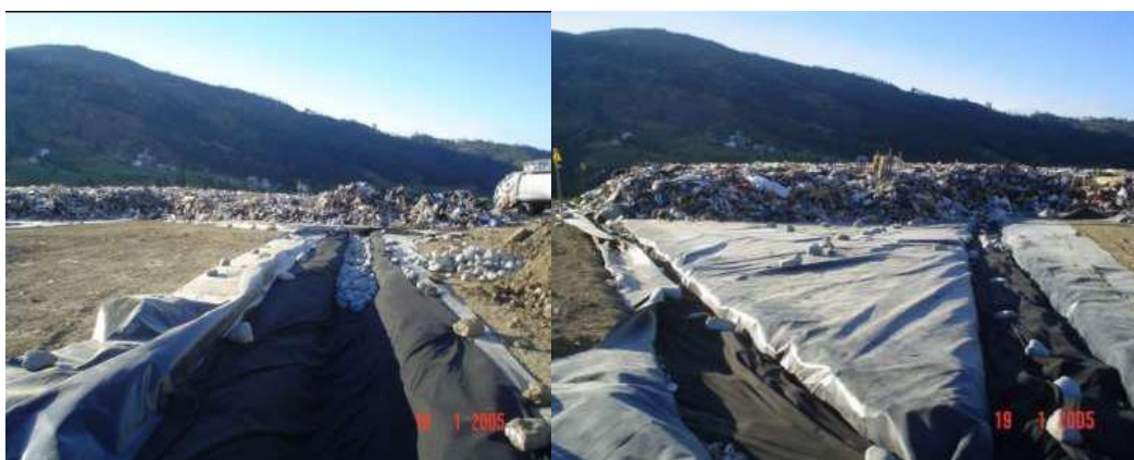
Figura No 42, 43. Construcción de drenes de lixiviados
