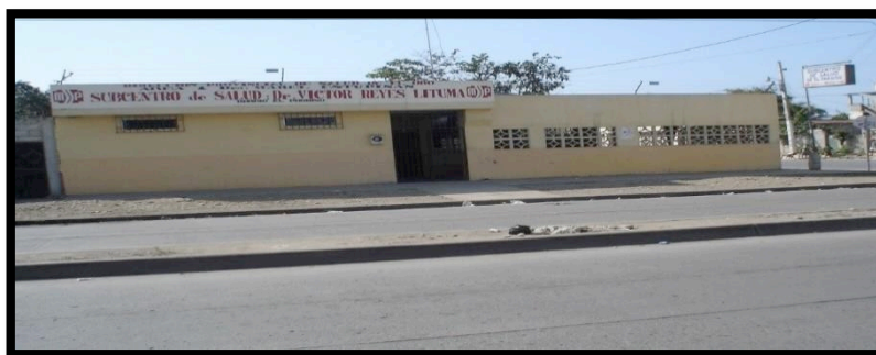
Figura N° 5: Centro de Salud Urbano El Paraíso
